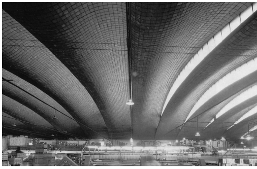
▲ FIG. 3 (IZQ). Bóvedas gausas de doble curvatura de Dieste cubriendo grandes luces (Archivo Dieste) FIG. 4 (DCHA). Sección tipo de los paneles prefabricados (Villá, 1993)
