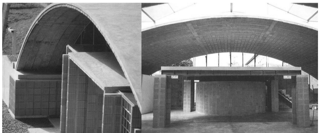
▼ FIG. 5. Bóvedas finalizadas en Unicamp mediante el sistema prefabricado (Villá, 1993)
