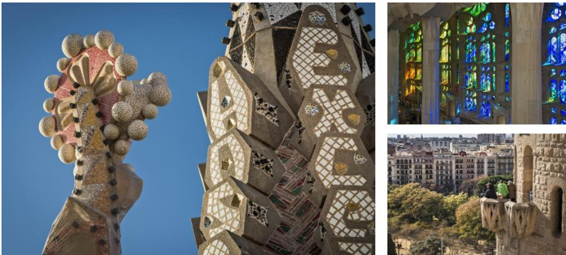
Figura 8. Detalles de las torres, de los vitrales y las vistas al exterior. Fuente: Portal Gaudí
