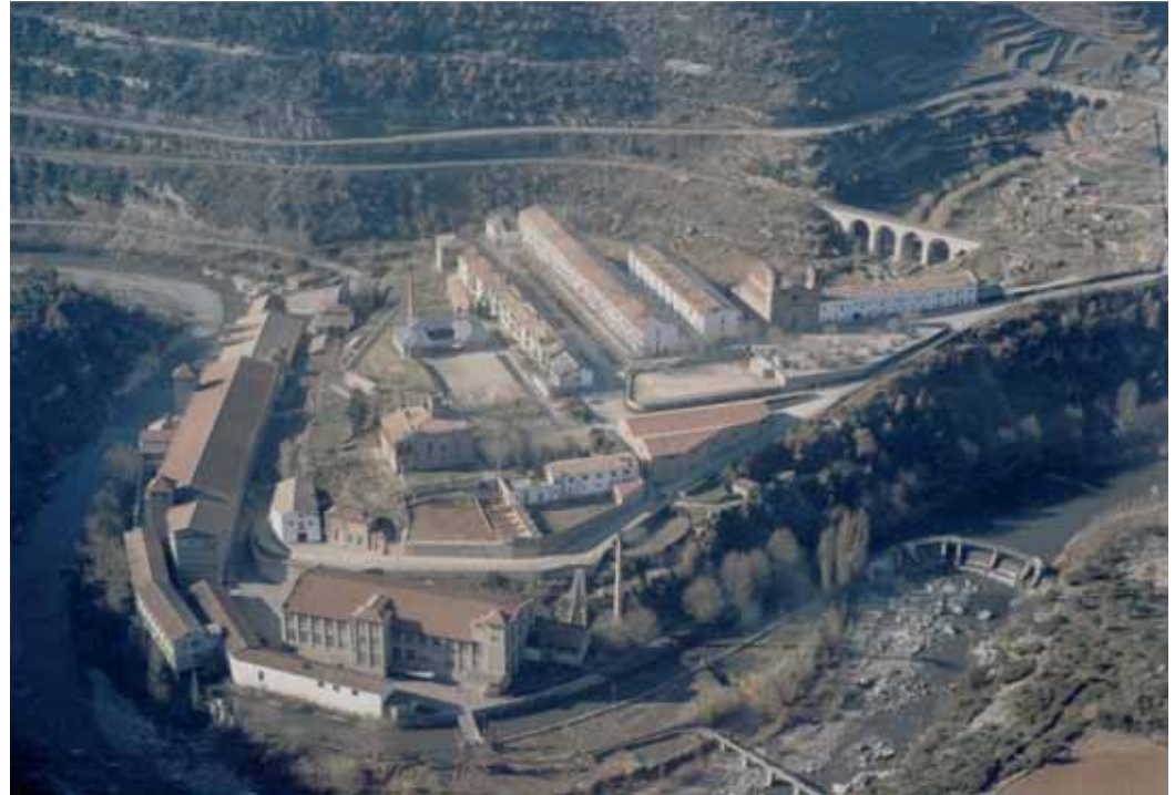
Figura 3: Vista aérea de la colonia Viladomiu Nou. Fuente: Paisajes Españoles, 1970.
